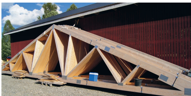
Takstolarna till nybygget.
