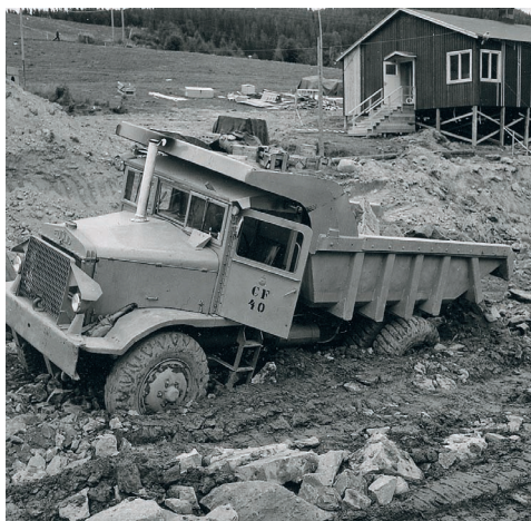
Arbetsförhållandens var många gånger besvärliga. Här vid bygget av kraftverksvägen vid Bärmon. Chaufför okänd. Foto 1955-09-13 av Åke Redin.
