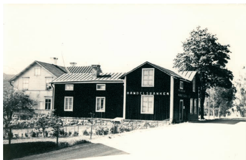
Lidens första apotek inrymdes i denna byggnad 1915-1917, varefter Svenska Handelsbanken flyttade in. Byggnaden, som låg på nuvarande adressen Lidenvägen 71, är numera riven. Foto troligen
