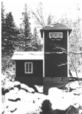
Järkvissle kraftstation, byggd i trä år 1923. Foto: Lidens Hembygdsförenings arkiv.
