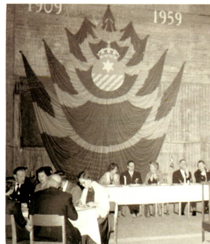
Honnörsbordet med den imponerande dekorationen på väggen. Statens Vattenfallsverk firade en av många 50-årsfester. Här i Järkvissle numera rivna maskinhall. Foto: Paul Nilsson.
