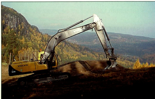
Vättabergets familjebacke har en hänförelse utsikt. Inför vintersäsong har många förbättringar gjorts i Vättabergets nedfarter, här byggs Familjebakens snowboardhopp. Foto: CATRIN BERTLIN
