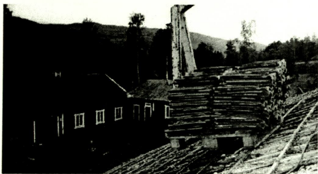
Tegeltaket från Jon-Andersgården skulle givetvis återanvändas. Panna för panna tvättas försiktigt för att inte förstöras
