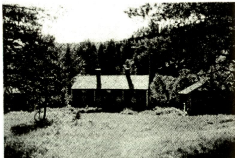
De byggnader som återstår idag vid sågen
