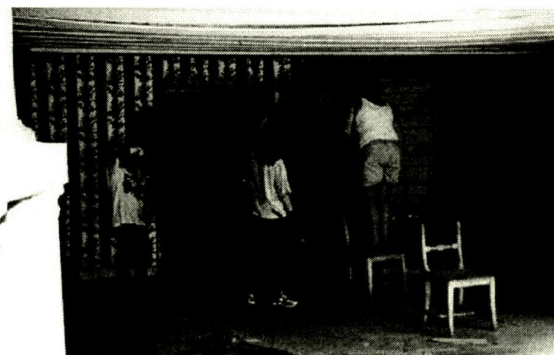
Tapeterna i Storsalen skärs försiktigt ned för att dokumenteras och bevaras för framtiden
